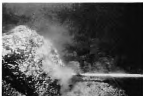
写真-1 WJによる剥離状況
